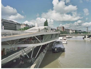
Schiffstation Wien City Schwedenplatz 1010 Wien
